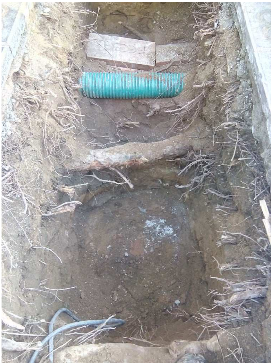
Vista de la cala 1, amb l'estructura UE 1004 localitzada sota els serveis contemporanis.
